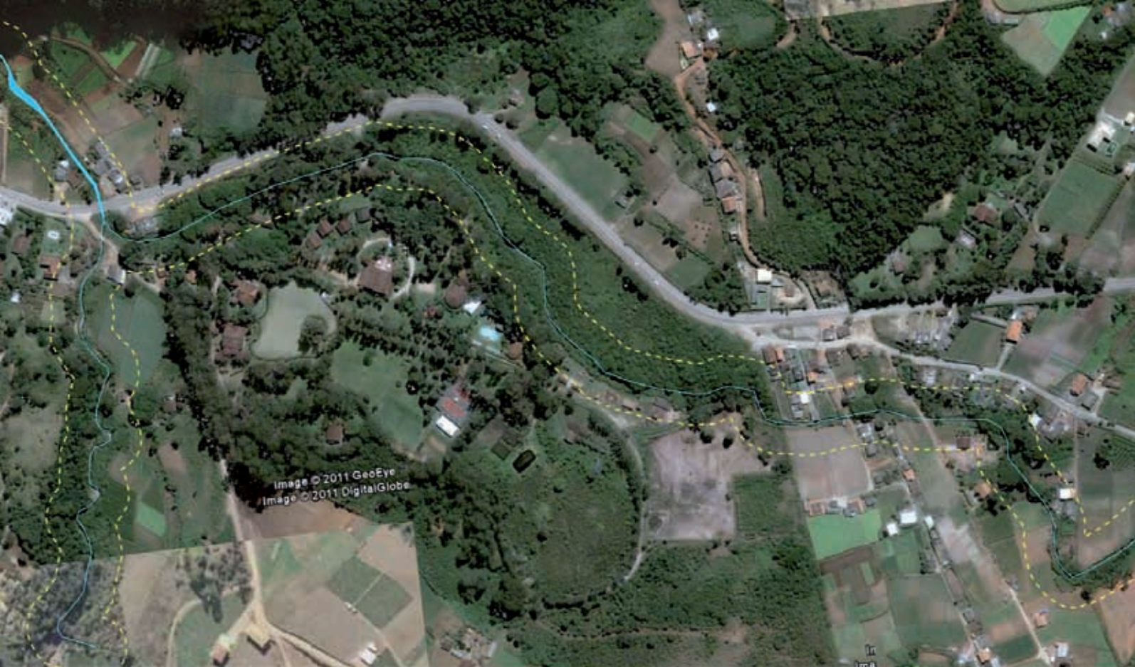
FIGURA 22: Vista da Vila de Vieira às margens do rio, e a ocupação do fundo de vale e das margens dos cursos d'água com edificações e plantações agrícolas. (Imagem Google Earth - 20.04.2010)
