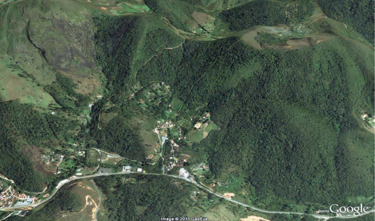
FIGURA 68: Região do Córrego Dantas em Nova Friburgo, localidade denominada Sítio dos Esquilos. Observa-se o topo de morro desmatado, estradas nas contruídas nas encostas e ocupação de fundo de vale nas margens do rio. (Imagem Google Earth - 12.10.2010)
