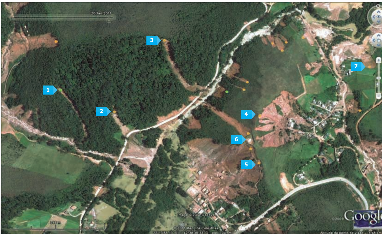
FIGURA 91: Nesta imagem estão assinalados locais onde houve deslizamentos que serão descritos a seguir. (Imagem Google Earth - 20.01.2011)
