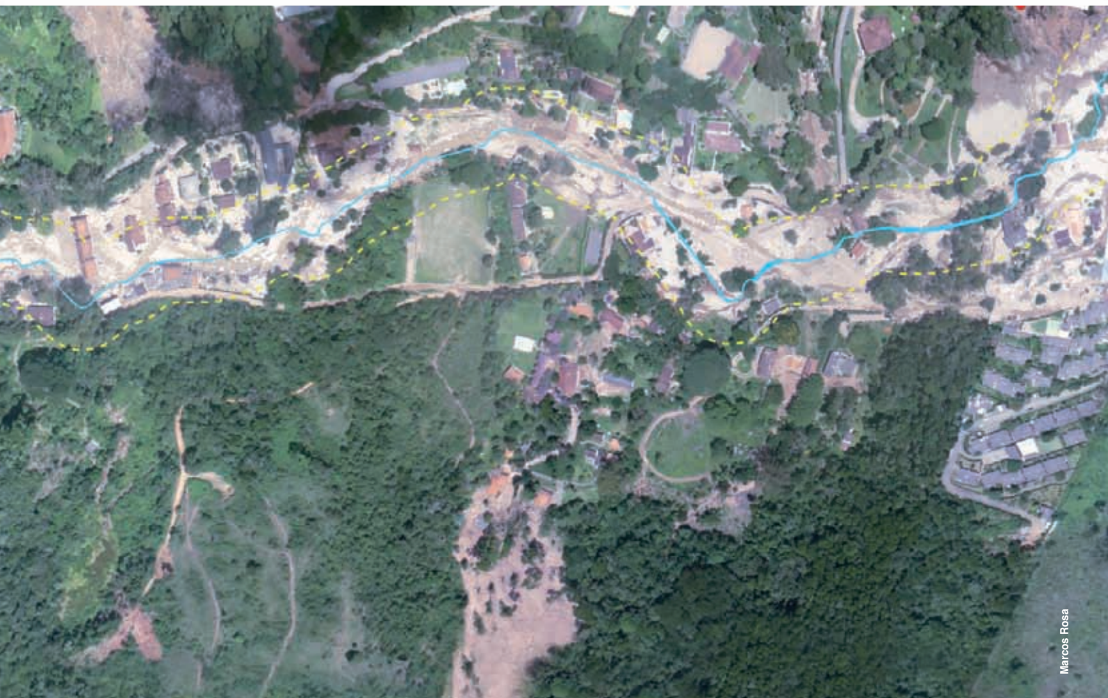
FIGURA 33: Vista aérea da vila do Bairro Campo Grande após a tragédia, mesma área da figura 32, mostrando os efeitos da inundação e corrida de lama e rochas sobre as casas e outras edificações ao longo do rio. Nota-se claramente que as áreas mais afetadas são aquelas situadas dentro da faixa de APP (delimitadas pela linha pontilhada amarela). (Foto aérea - 26.01.2011)
