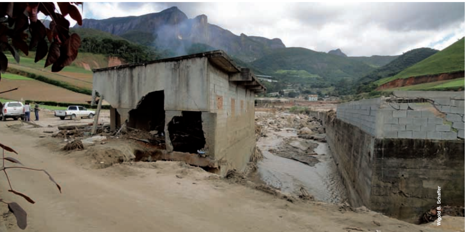
FIGURA 19: Localidade de Bonsucesso em Teresópolis-RJ. Na foto aparece em detalhe o tamanho do rio, mostrando sua pequena largura (menos de 5 metros). Além de edificações, logo a montante da ponte, literalmente em cima de ambas as margens, observa-se também que o rio era parcialmente canalizado. (Foto - 24.01.2011)
