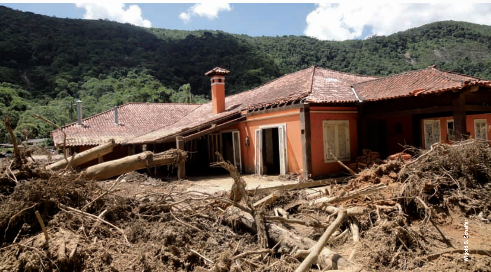
FIGURA 46: Vale do Cuiabá em Petrópolis. A foto mostra casa destruída pela força das águas. Nesta casa, construída à margem do rio (parcialmente dentro de APP) e localizada a aproximadamente 200 metros a jusante da ponte representada na Figura 50, morreram 9 pessoas. (Foto - 25.01.2011)
