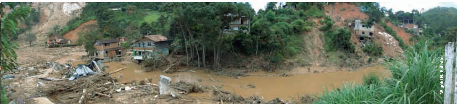
FIGURA 70: Região do Córrego Dantas em Nova Friburgo, localidade denominada Sítio dos Esquilos. Observa-se edificações construídas às margens do rio (APP) e encostas com mais de 45° (APP), destruídas pelos deslizamentos e enchentes. (Foto - 24.01.2011)
