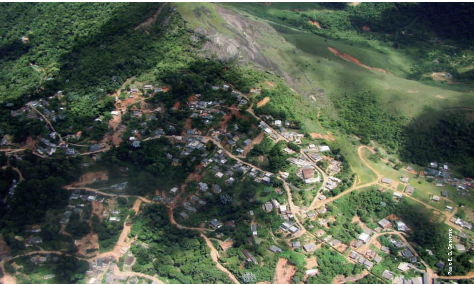
FIGURA 43: Bairro Granja Florestal em Teresópolis, mesma área da figura 42. Notam-se diversos deslizamentos associados às estradas ou intervenções para edificações. (Foto aérea - 26.01.2011)
