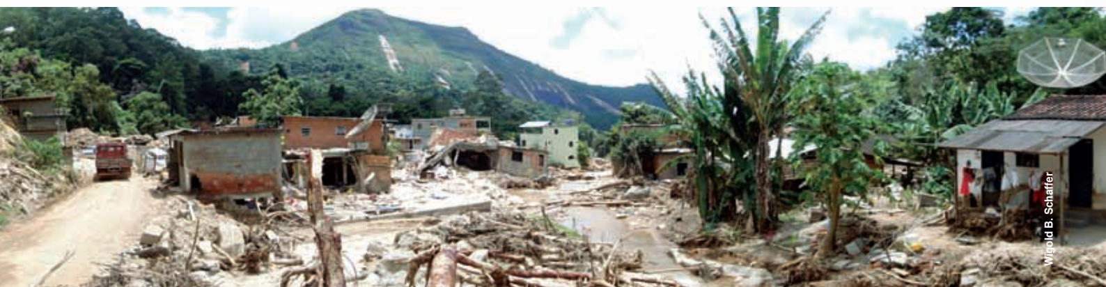
FIGURA 29: Vista geral da destruição provocada pela força da água às margens do afluente do rio na vila do Bairro Campo Grande em Teresópolis. (Foto - 25.01.2011)
