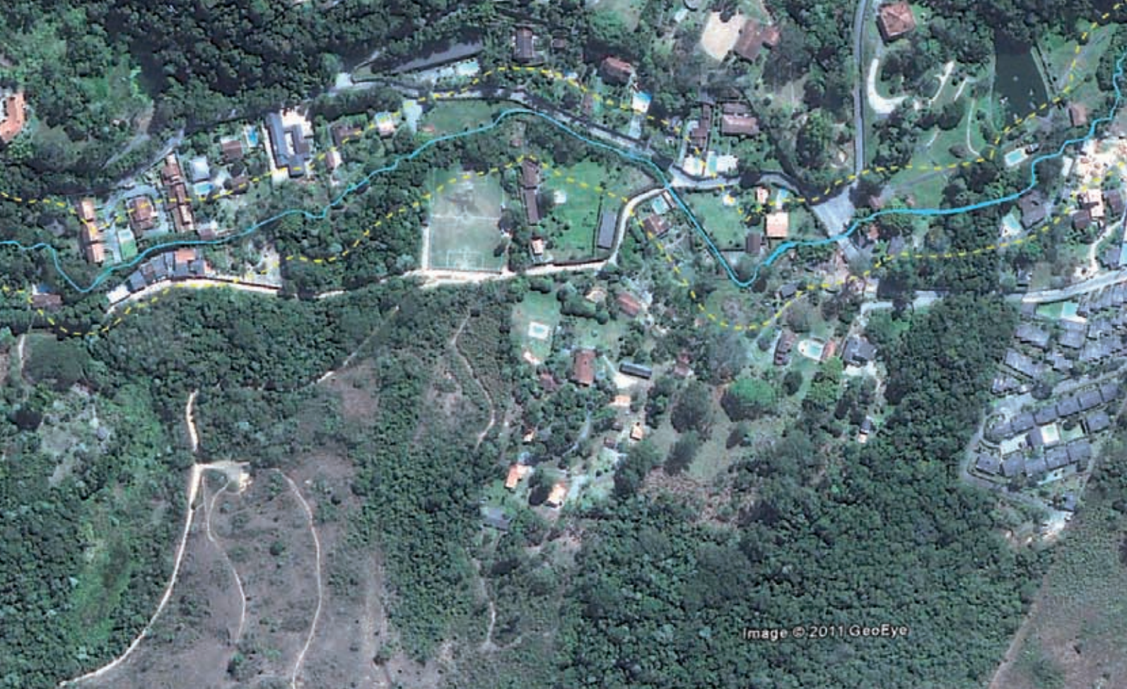
FIGURA 32: Vista da vila do Bairro Campo Grande em Teresópolis, e a ocupação do fundo de vale e das margens dos cursos d'água com moradias e outras edificações. (Imagem Google Earth - 30.08.2010)
