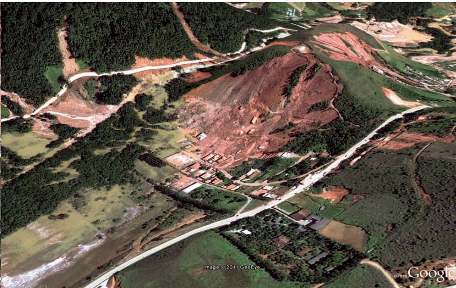
FIGURA 75: Condomínio do Lago, BR 492 em Nova Friburgo, mesma área da figura 74. Observa-se deslizamento associado à intervenção humana (construção de estradas e topo de morro desmatado). No condomínio morreram 9 pessoas. (Imagem Google Earth - 19.01.2011)
