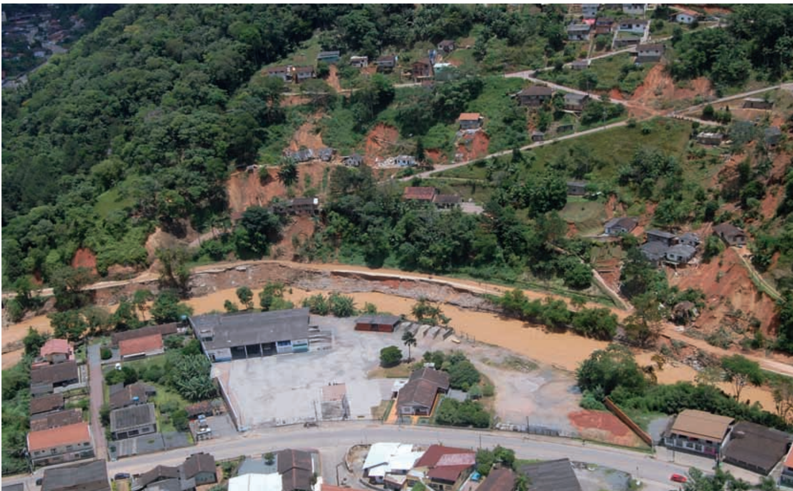
FIGURA 3: Deslizamento em área de risco ocupada (APP de margem de rio e encosta com mais de 45°) no Bairro Progresso em Blumenau-SC. Nota-se no lado esquerdo da foto que a área com vegetação nativa bem preservada não foi afetada. Observa-se também a associação dos deslizamentos com os cortes feitos no morro para construção de estradas e moradias. (Divulgação/Foto: Eraldo Schneider – 30.11.2008)
