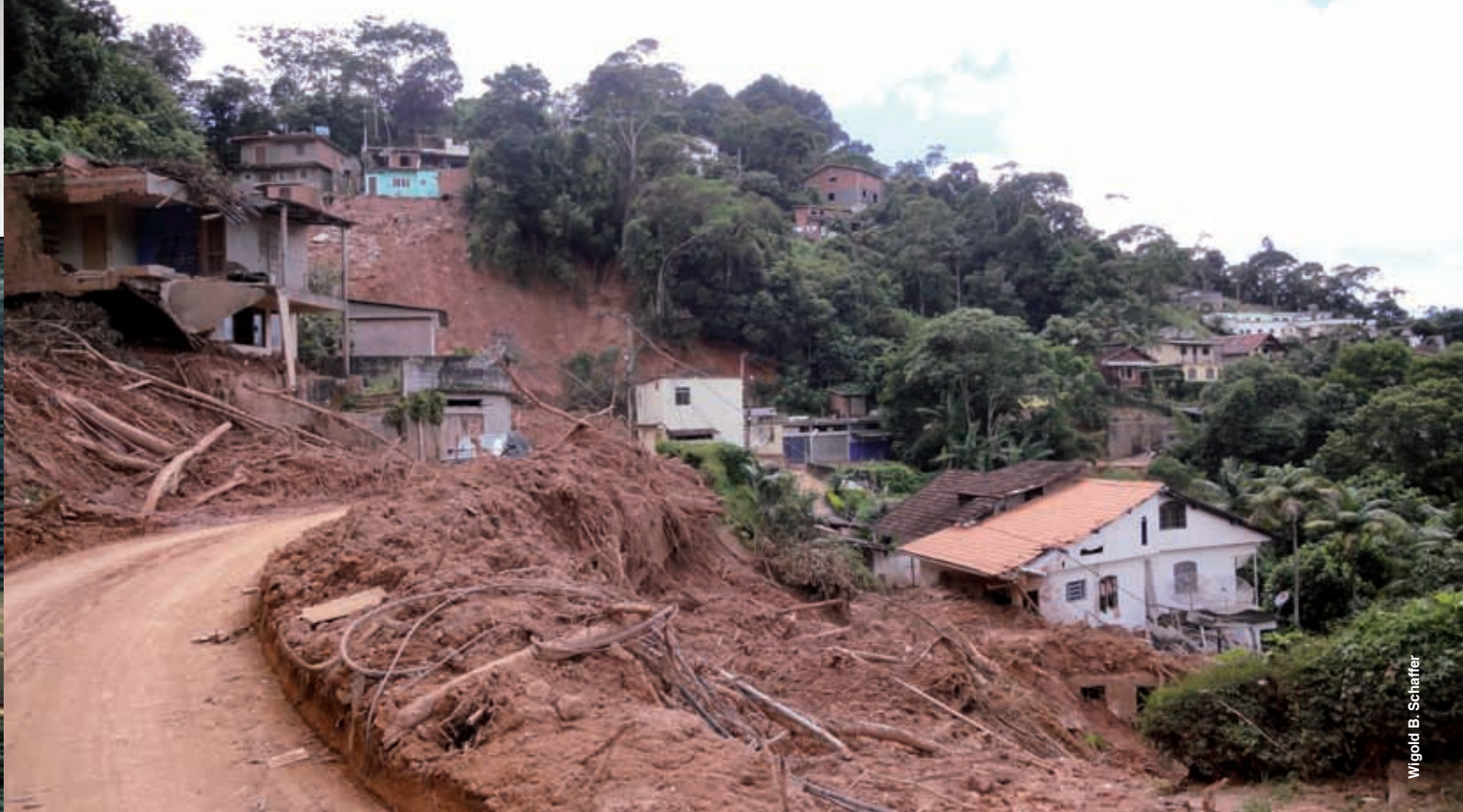
FIGURA 44: Bairro Granja Florestal em Teresópolis. É possível observar diversos deslizamentos e destruição de casas edificadas em áreas com inclinação acima de 45° (APPs). (Foto - 25.01.2011)
