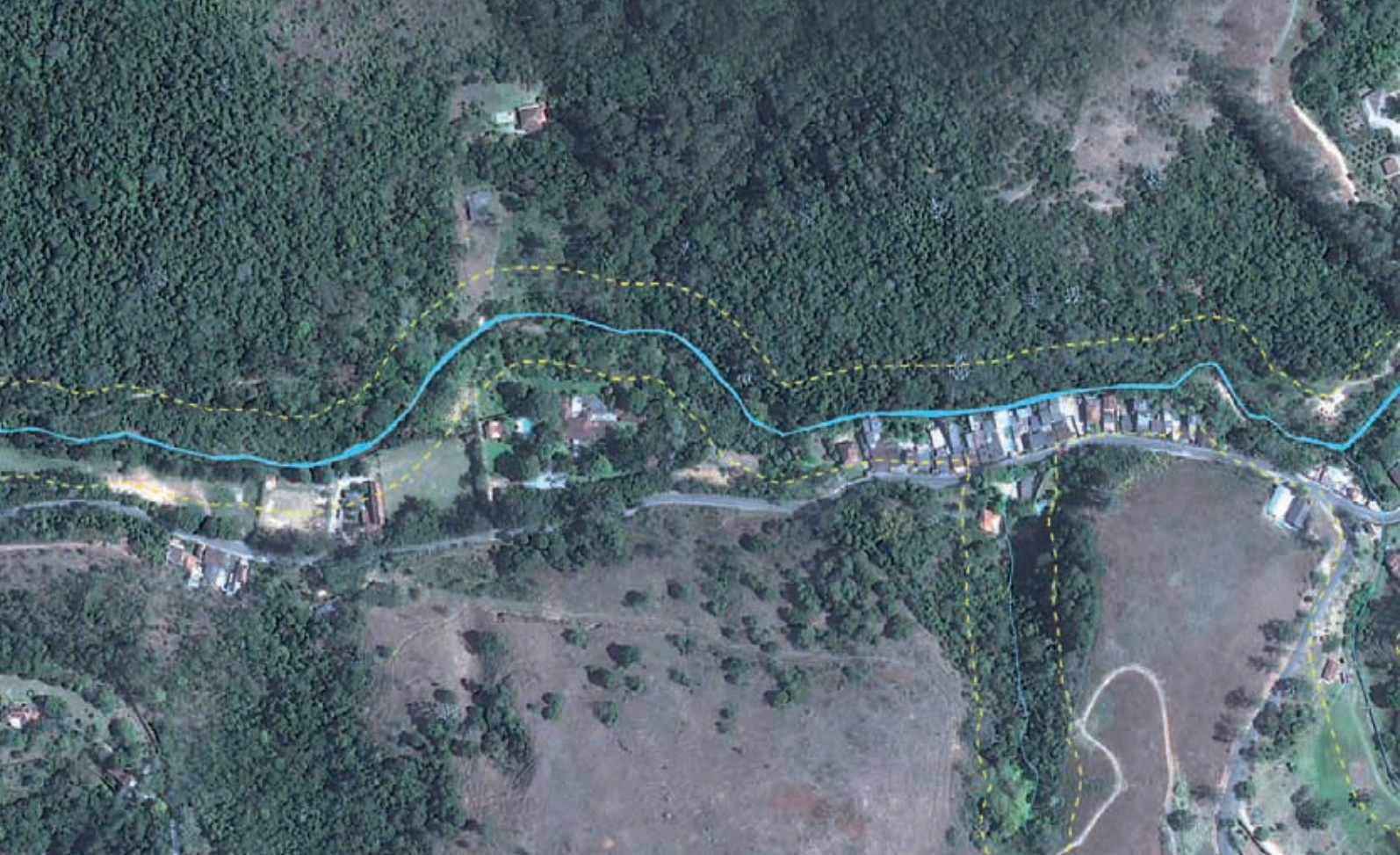
FIGURA 51: Vale do Cuiabá em Petrópolis. A imagem mostra a ocupação adensada às margens de diferentes trechos do rio, em APP. (Imagem Google Earth - 2009)
