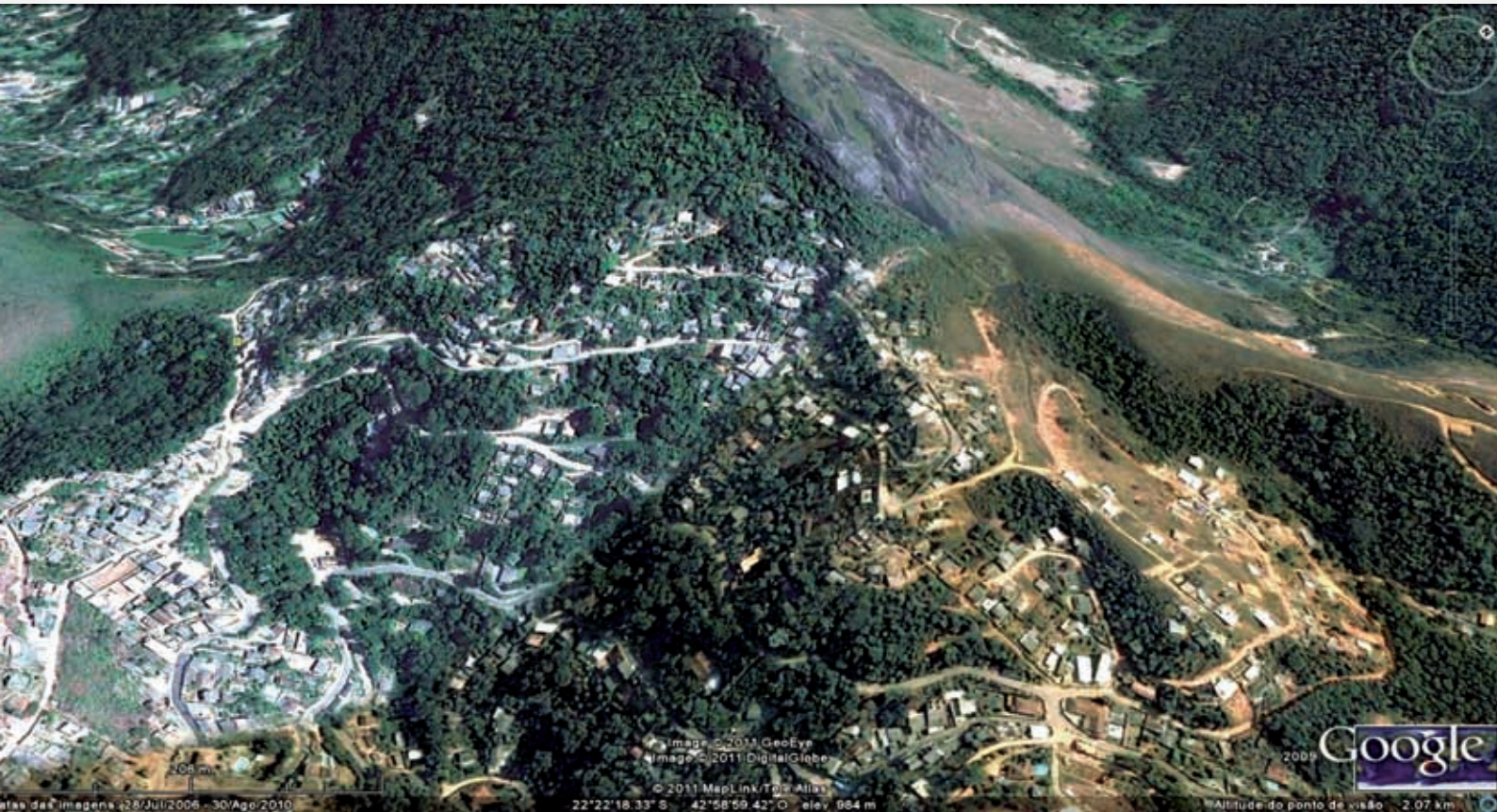
FIGURA 42: Bairro Granja Florestal em Teresópolis. Imagem mostra ocupação de área de alta declividade (~ entre 30 e 70°). Nota-se uma série de arruamentos construídos em curva de nível, bem como ligações entre estes arruamentos. Há também cortes (terraplanagem) no morro para construção das edificações. (Imagem Google Earth - 2006/2010)
