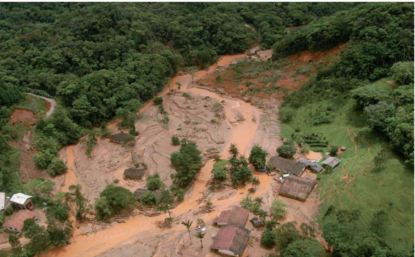
FIGURA 5: Casas e outras edificações construídas em APP de margem de curso d'água, atingidas por corrida de lama na região do Morro do Baú em Ilhota-SC. (Divulgação/Foto: Fabio Fáraço – 30.11.2008)
