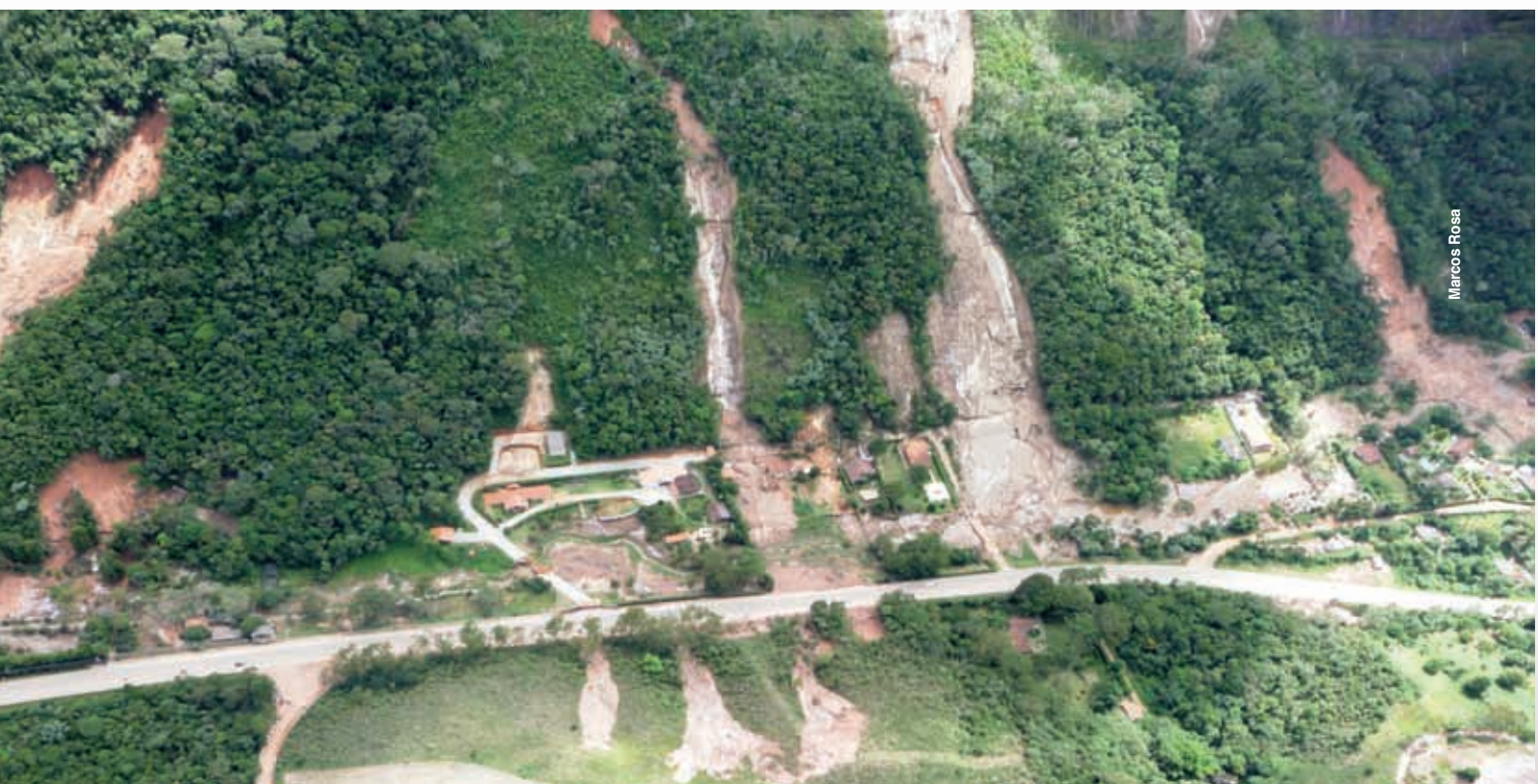
FIGURA 62: BR 492 em Nova Friburgo, mesma área da figura 61, mostrando deslizamentos na encosta que atingiram diversas casas localizadas às margens do riacho e no sopé de morro com inclinação superior a 45°. Nota-se também que entre as casas e a encosta há uma estrada pavimentada, mostrando que houve intervenção na base do morro. (Foto aérea - 26.02.2011)
