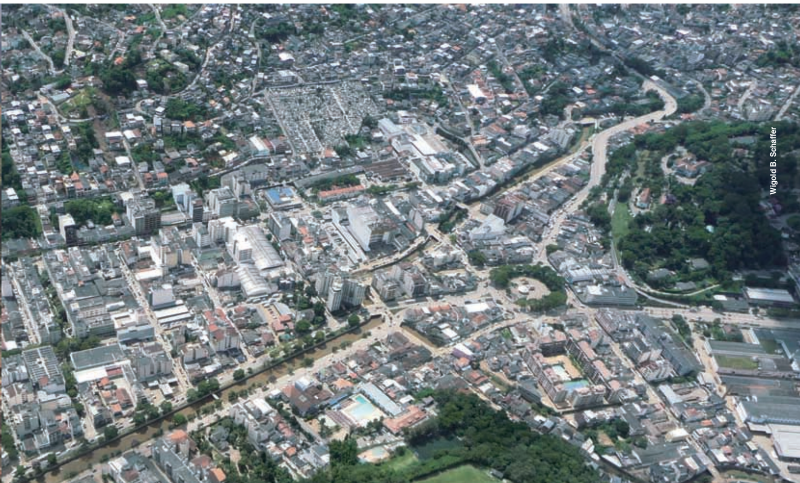
FIGURA 88: Nova Friburgo, mesma área da figura 87. Canais com ângulos fechados e pontes baixas dificultam a passagem da água, agravando localmente os efeitos da inundação. (Foto aérea - 26.01.2011)
