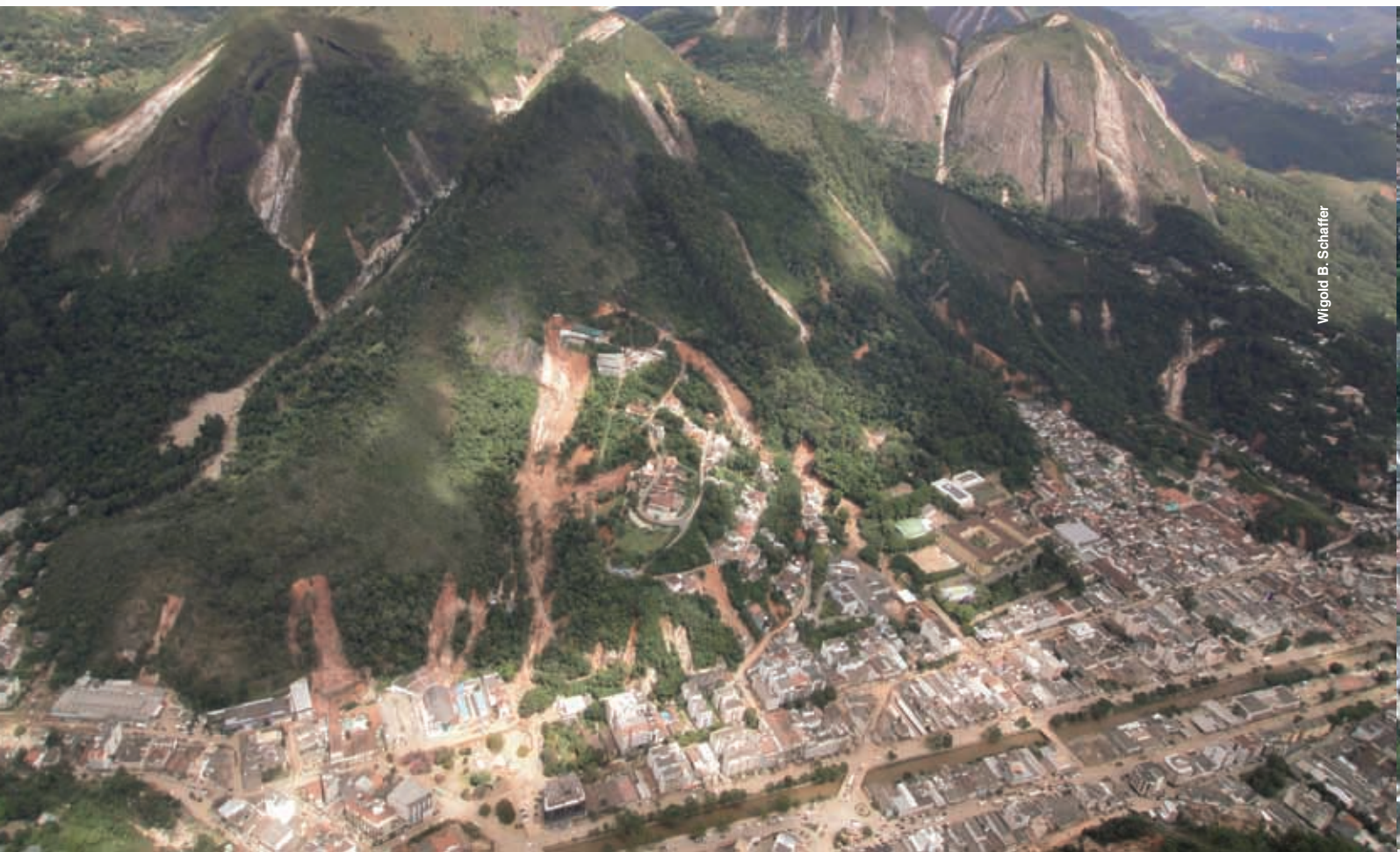
FIGURA 86: Nova Friburgo, mesma área da figura 85. Pode-se observar deslizamentos na encosta ocupada, e a lateral do rio (canalizado) totalmente ocupada por edificações, as quais foram afetadas pela inundação. Foram também afetadas as edificações construídas próximo ao sopé da montanha. Mais ao fundo observa-se deslizamentos de rochas e terra provenientes do topo dos morros e montanhas, evidenciando o grau de risco para as ocupações das encostas e aquelas localizadas no sopé dos respectivos morros e montanhas. (Foto aérea - 26.01.2011)
