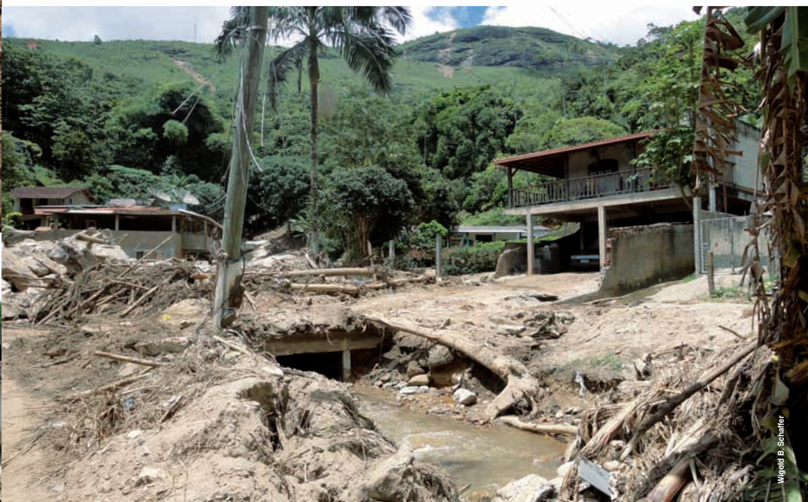
FIGURA 31: Pequenas pontes com vão reduzido que se tornam represas, intensificando localmente os efeitos e extensão das inundações. Vila do Bairro Campo Grande em Teresópolis. (Foto - 25.01.2011)
