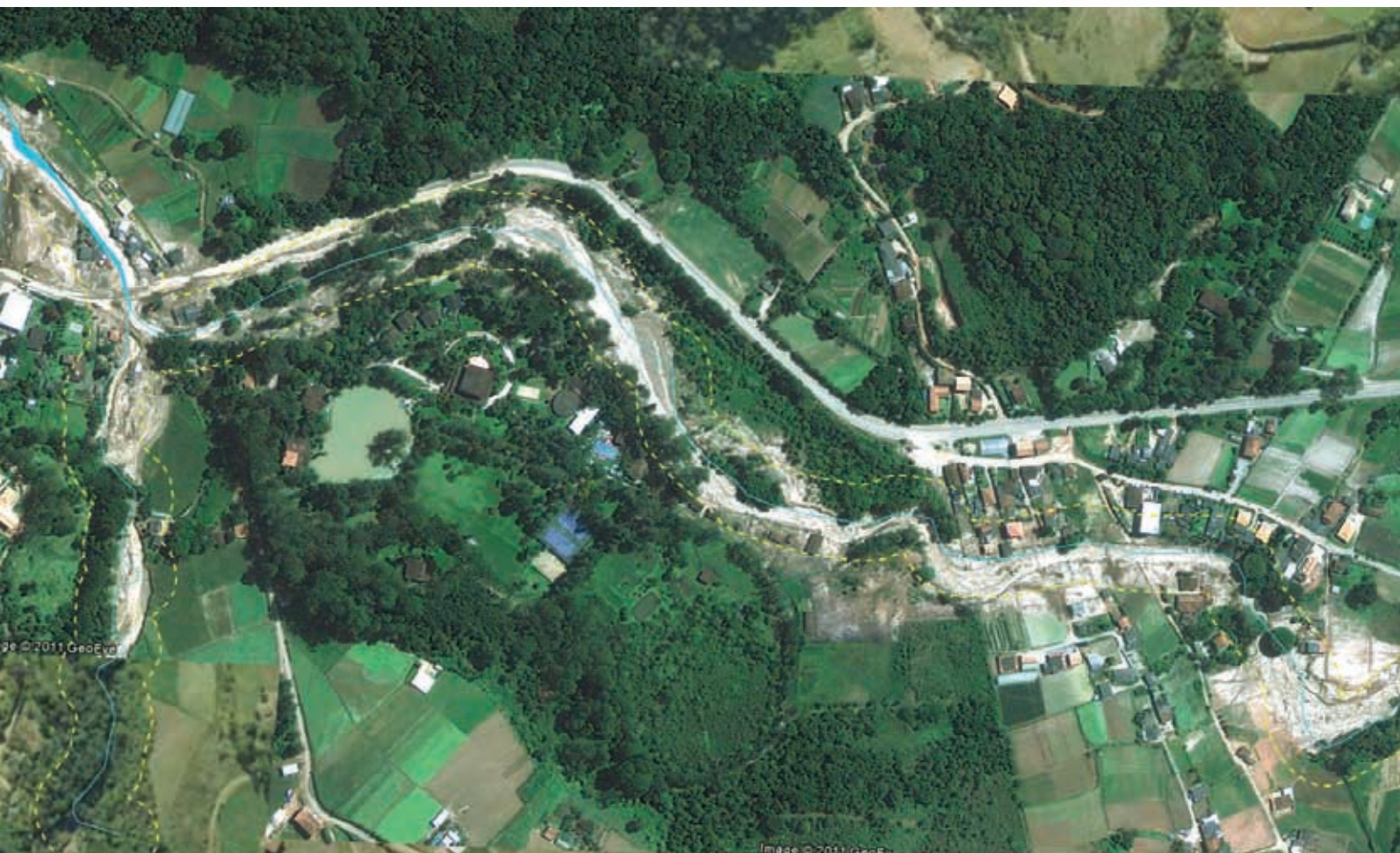
FIGURA 23: Vista da Vila de Vieira, mesma área da figura 22, mostrando a inundação e corrida de lama que afetou o fundo do vale ocupado com habitações e agricultura. Observa-se que a faixa de APP (delimitada por linha amarela pontilhada) foi severamente atingida. (Imagem Google Earth - 20.01.2011)
