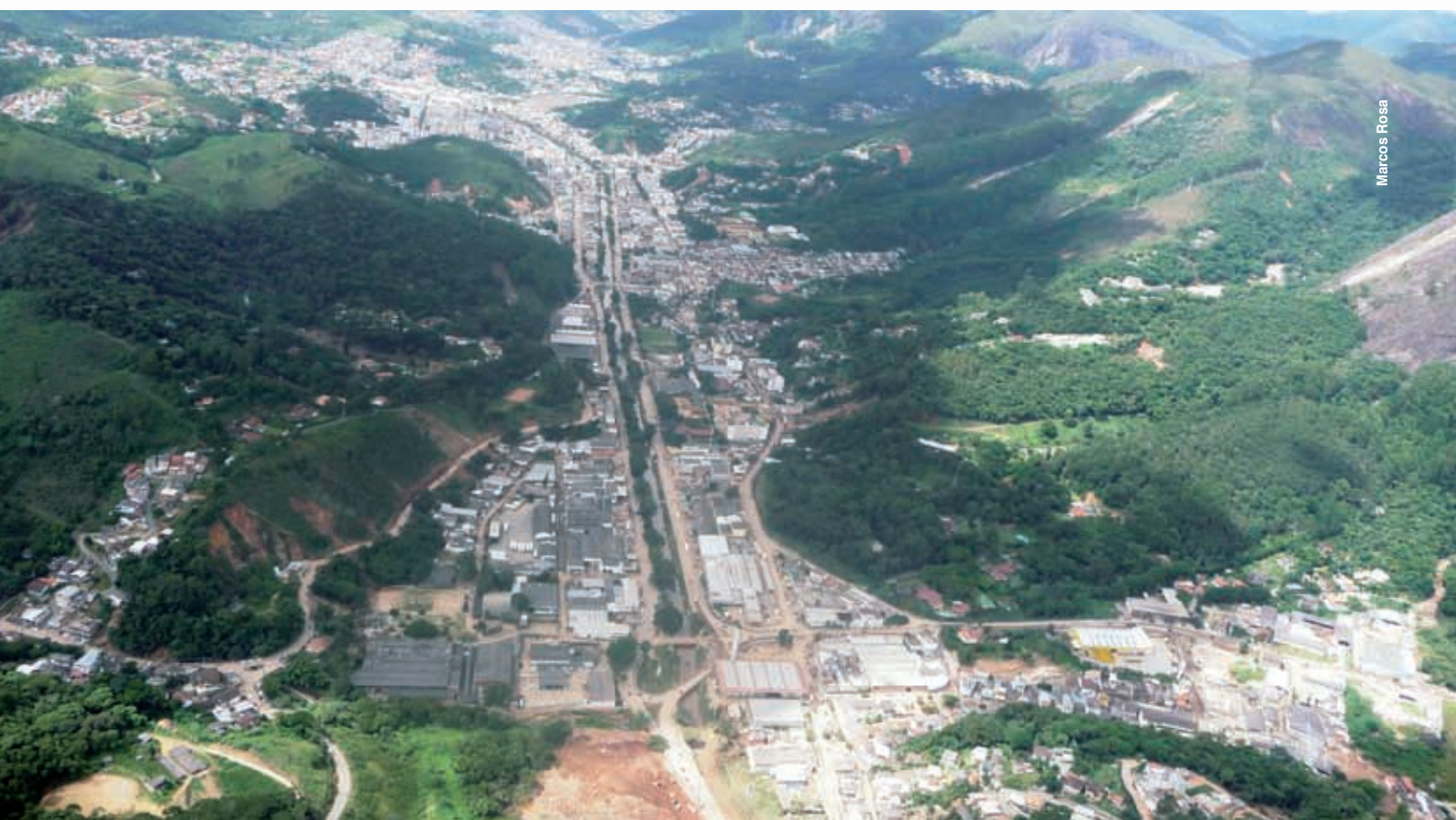
FIGURA 82: Cidade de Nova Friburgo, mesma área da figura 81. Observa-se vestígios do transbordamento do rio canalizado, que inundou todas as edificações nas laterais do canal. (Foto aérea - 26.01.2011)
