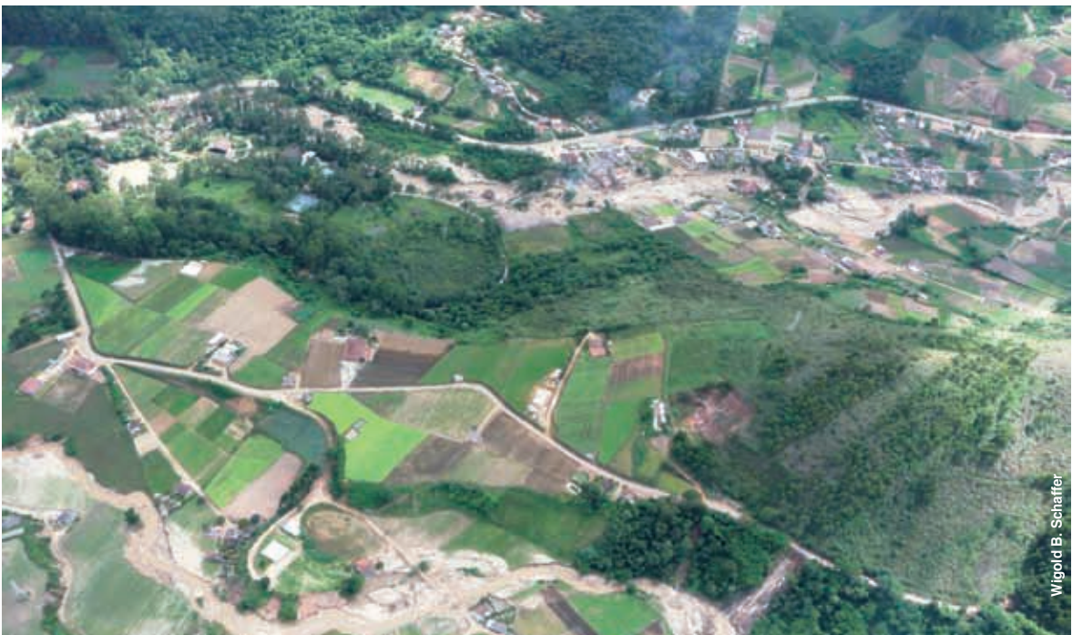
FIGURA 21: Vista da área rural do Alto Vieira, alguns quilômetros a montante da Vila de Vieira mostrando o comprometimento de lavouras, destruição de edificações, erosão e desestabilização das margens do rio. (Foto aérea - 26.01.2011)
