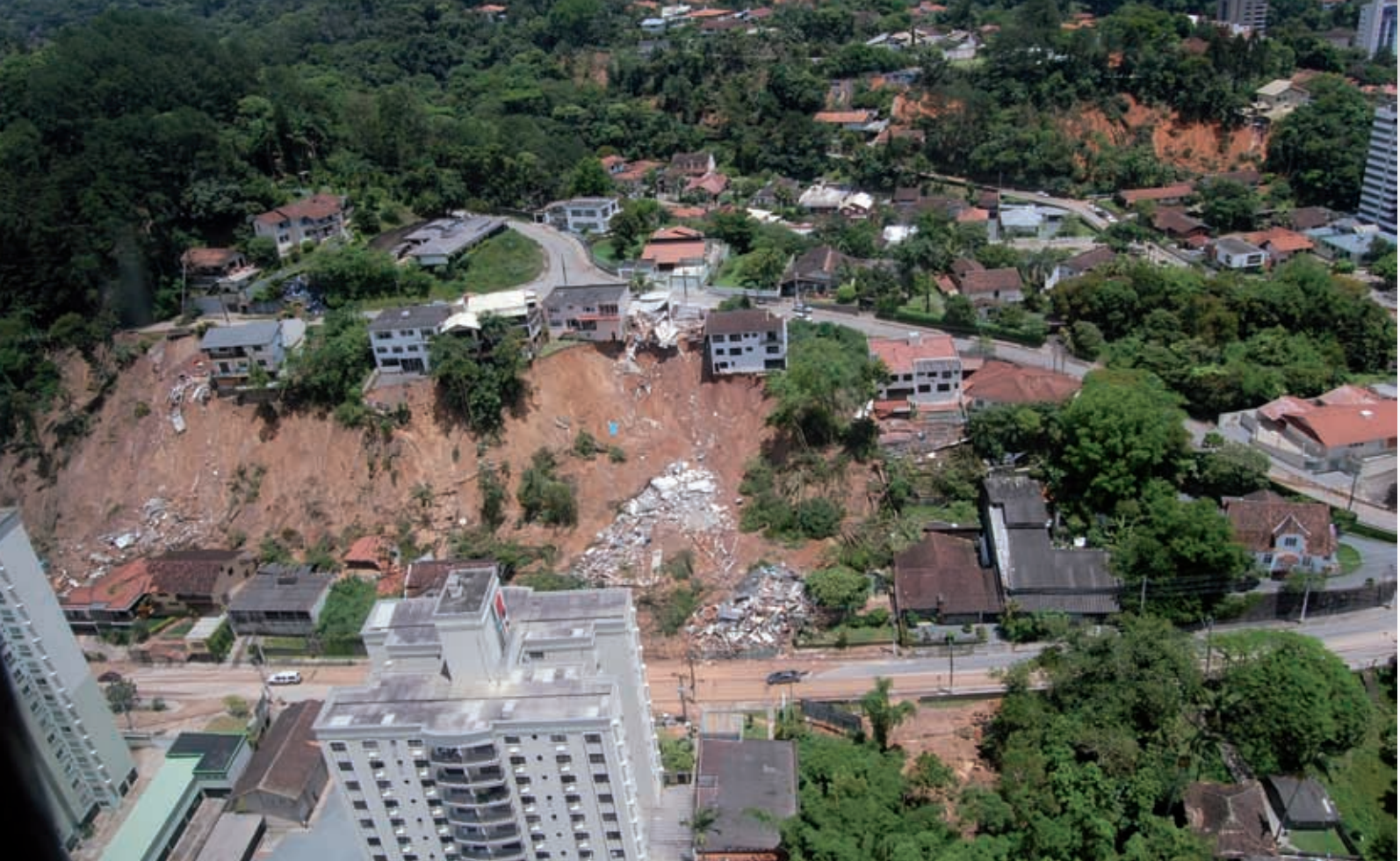
FIGURA 4: Deslizamento em área de risco ocupada (APP de encosta com mais de 45°) em Blumenau-SC. Observa-se a associação de ocupação de encosta com alta declividade e cortes feitos para construção de estradas e moradias. (Divulgação/Foto: Fabio Fáraço – 30.11.2008)
