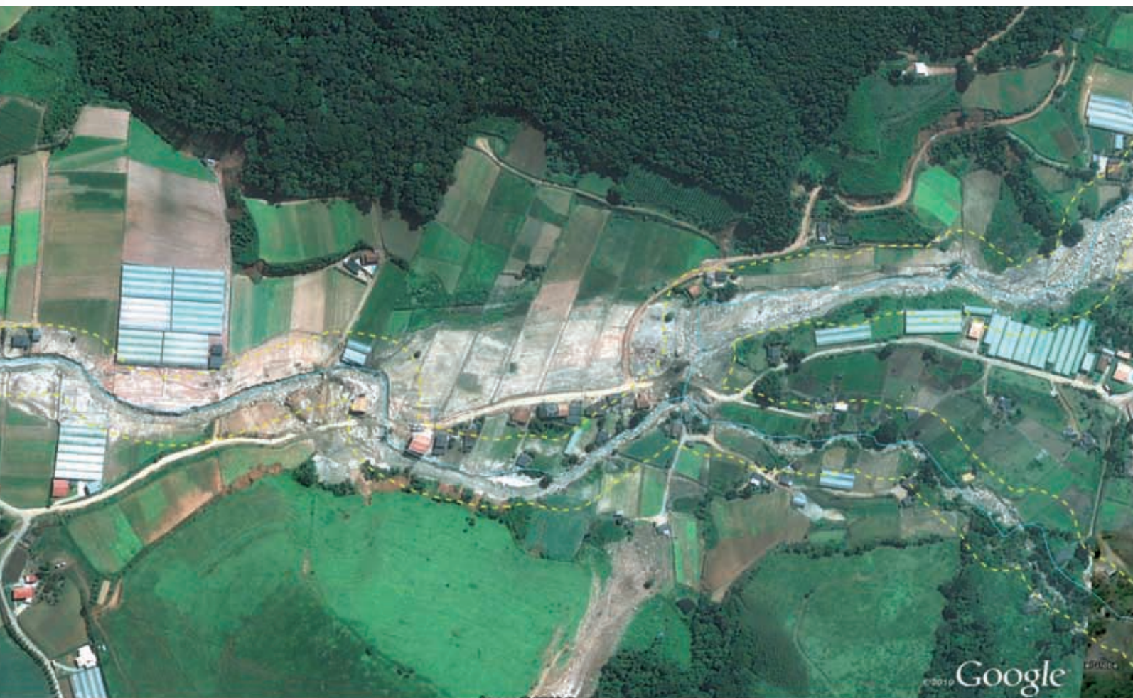
FIGURA 17: Localidade de Bonsucesso em Teresópolis-RJ, mesma área da figura 16. A imagem mostra que as áreas mais severamente atingidas são aquelas situadas às margens dos cursos d'água, com grandes danos às construções, perda das lavouras e intensa erosão do solo. (Imagem Google Earth - 20.01.2011)
