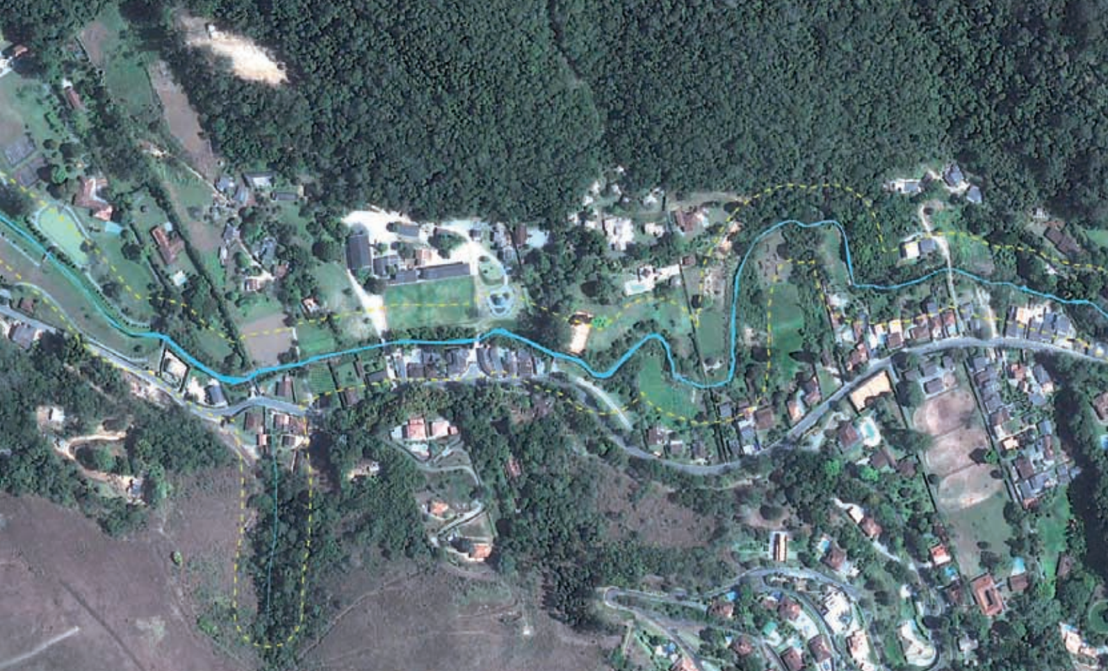
FIGURA 53: Vale do Cuiabá em Petrópolis. Neste trecho observa-se a ocupação do vale com edificações diversas e atividades de lazer e esporte, inclusive em áreas dentro da faixa de APP de 30 metros em cada lado da margem dos cursos d'água, área delimitada por linha pontilhada amarela. (Imagem Google Earth - 2009)
