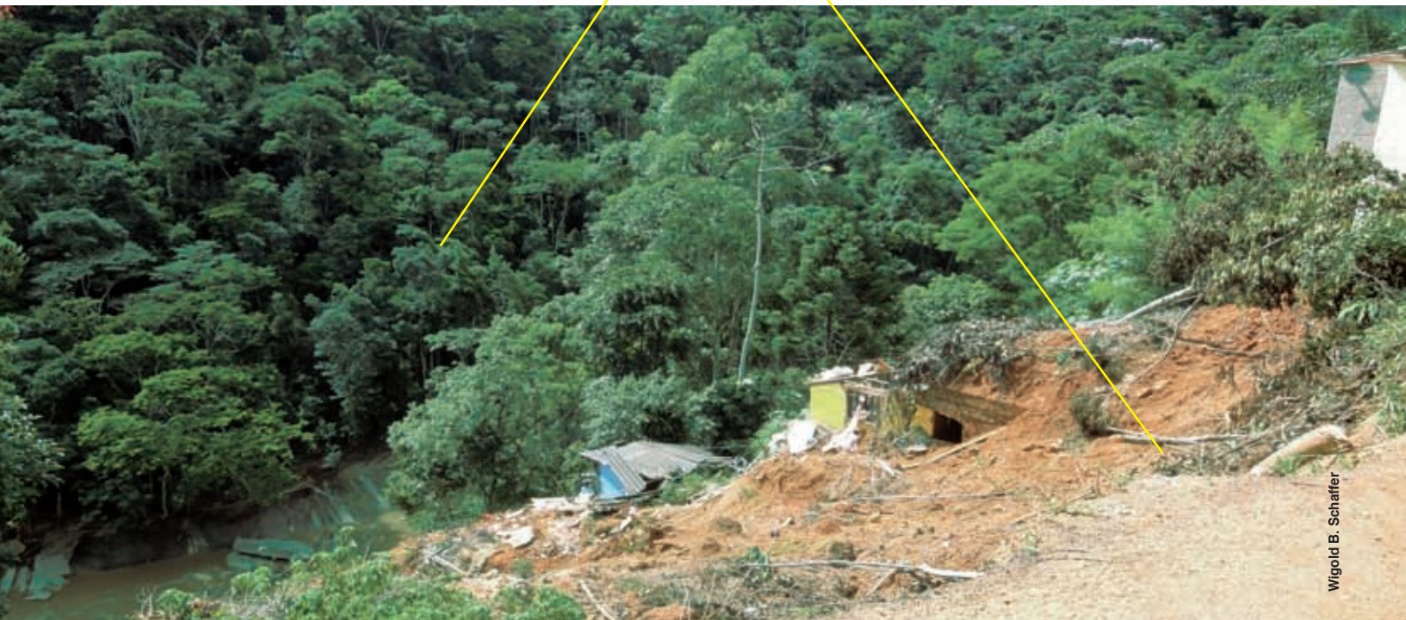
FIGURA 39: Detalhe de casas atingidas por desmoronamento, localizadas em APP de margem de rio e inclinação superior a 45°. Na margem oposta do rio, a vegetação permaneceu intacta. (Foto - 25.01.11)
