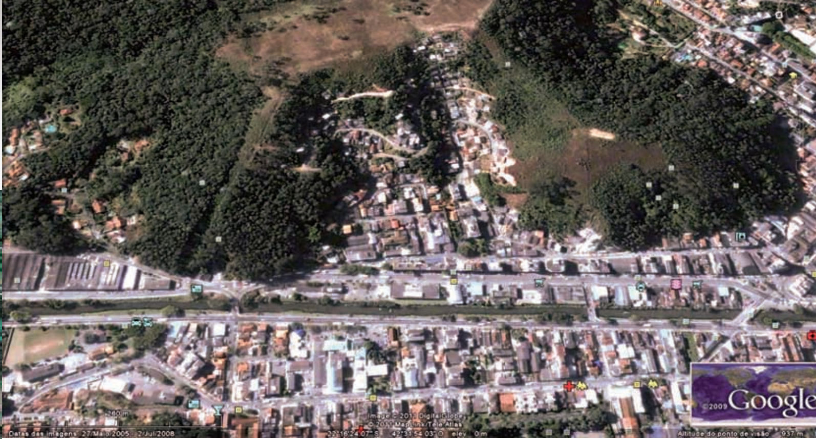
FIGURA 83: Detalhe da cidade de Nova Friburgo. Destaque para a ocupação de encostas com alta declividade, construções no sopé dos morros e o rio canalizado. (Imagem Google Earth - 2010)
