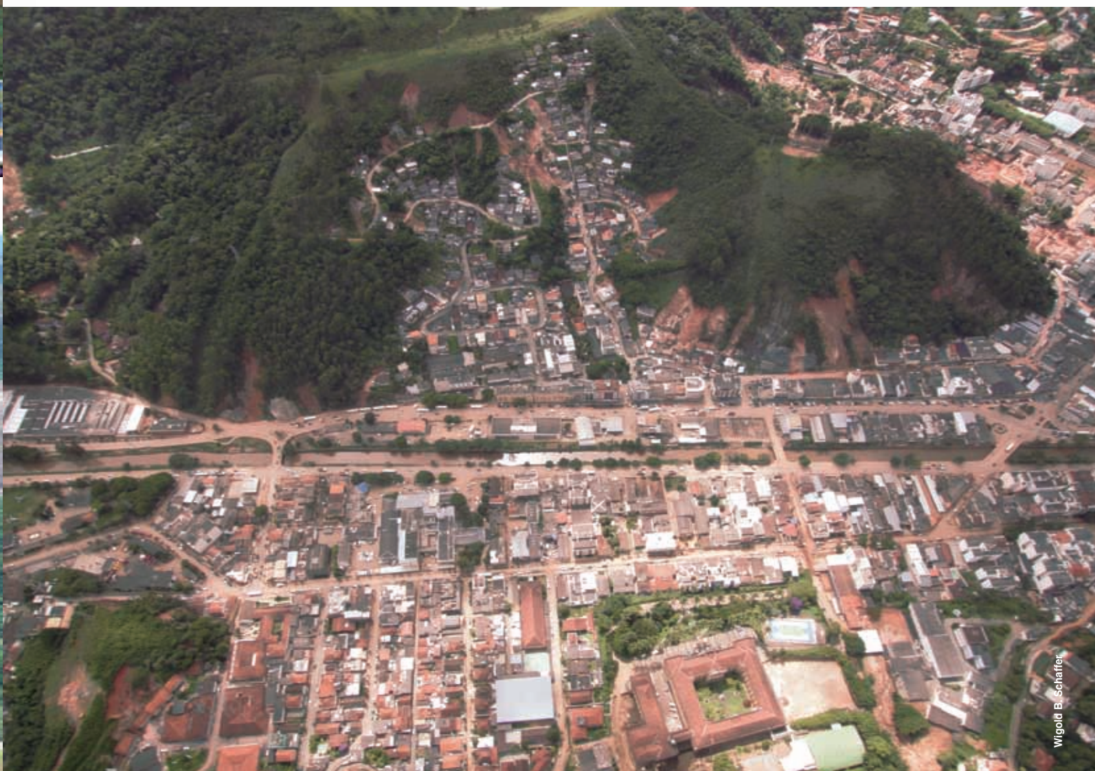
FIGURA 84: Nova Friburgo mesma área da figura 83. Pode-se observar deslizamentos na encosta ocupada, e a lateral do rio (canalizado) totalmente ocupada por edificações, as quais foram afetadas pela inundação. (Foto aérea - 26.01.2011)
