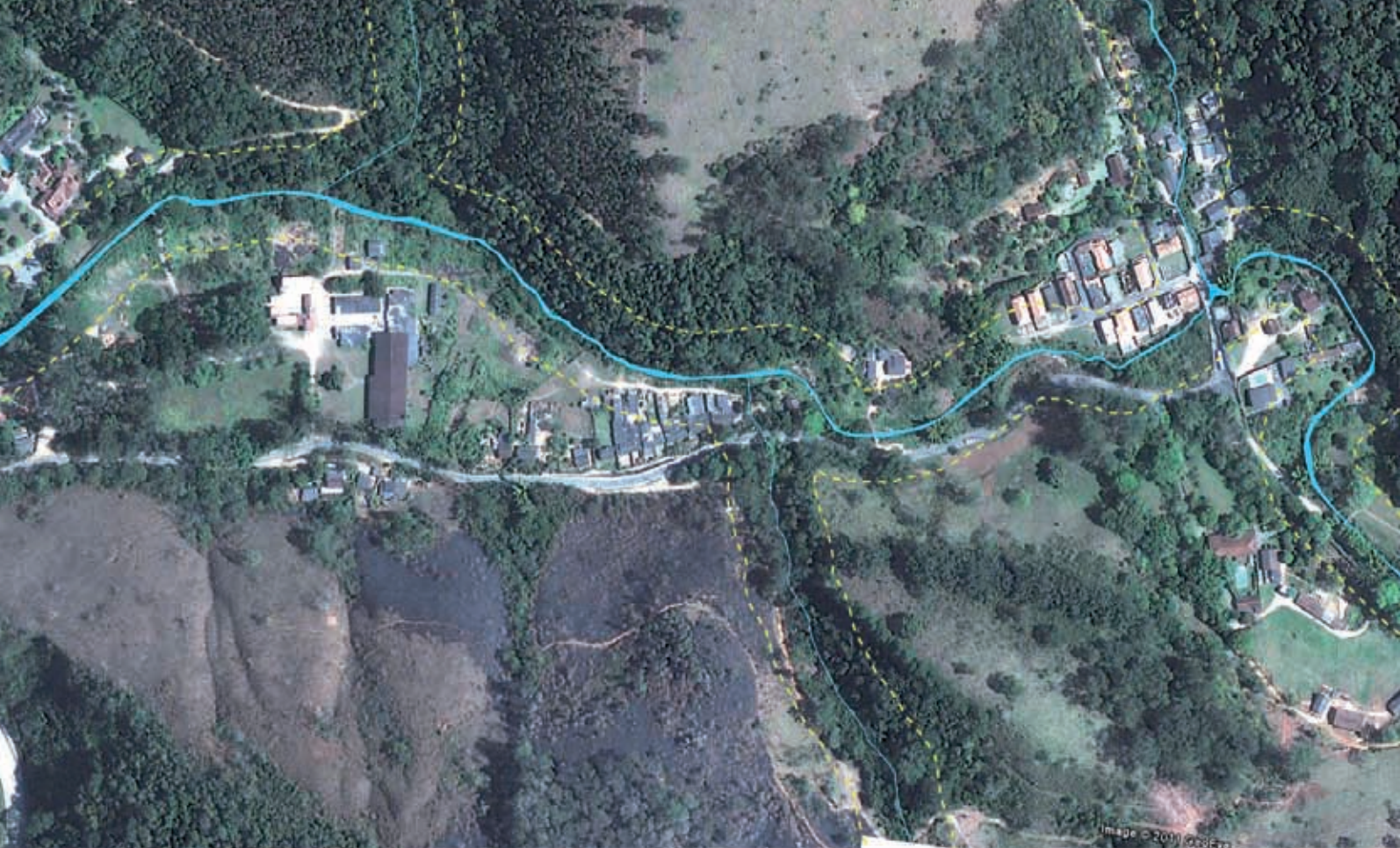
FIGURA 55: Vale do Cuiabá em Petrópolis. Neste trecho podem ser observadas diversas construções junto ao encontro de dois rios e nas suas margens. (Imagem Google Earth - 2009)
