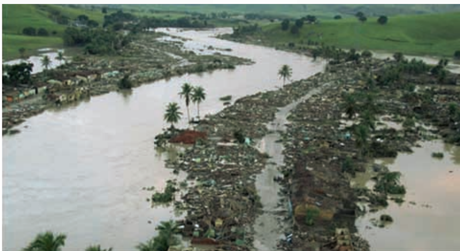
FIGURA 13: União dos Palmares, a 80 km de Maceió-AL. A foto mostra que a área mais duramente afetada é a faixa de APP (50 m em cada lado do rio). (Divulgação/Foto: Thiago Sampaio/Agência Alagoas) 18
